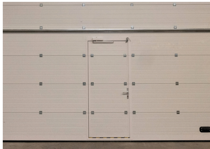
Portillon incorporé équipé d'un ferme-porte et d'une serrure à mortaise.
