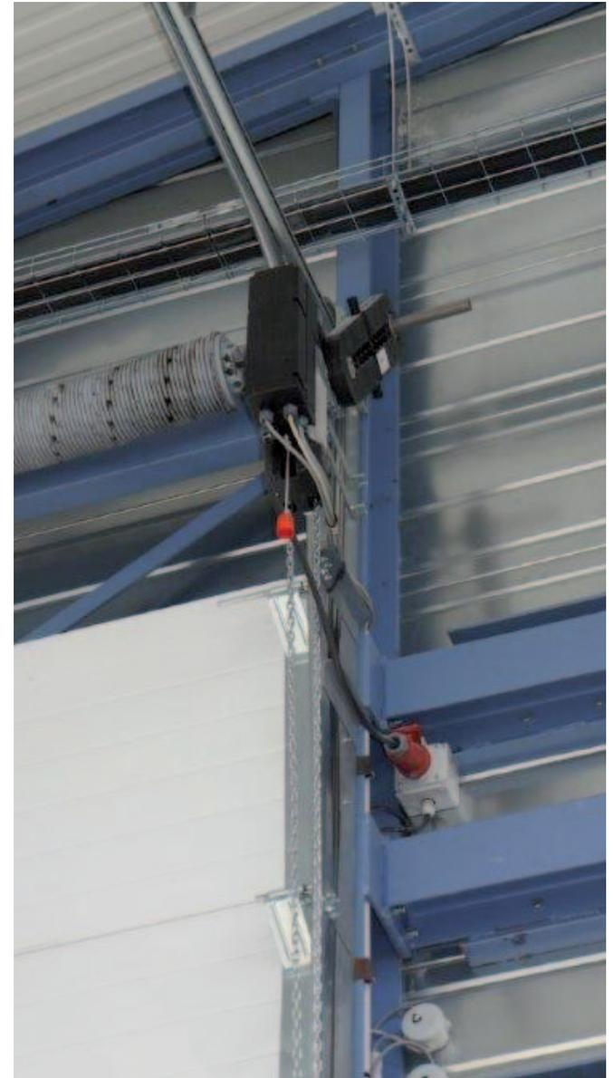
Principe de montage du moteur avec transmission carénée
